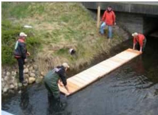
Um den Abfluss zu gewährleisten wurde hier anstelle einer festen Bërme eine Schwimmbërme favorisiert. Nach Erfahrungen aus der Eider-Treene-Sorge Niederung bauten die "Schwentine Ranger" eine solche Schwimmbërme, die 2008 unter der Brücke installiert wurde. Die Bërme erfüllt die Funktion des für den Fischotter sehr wichtigen Uferstreifens, und soll den Ausstieg aus dem Gewässer und die Querung der Straße verhindern.
